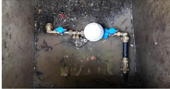
Réparation fuite avant compteur 10 rue des Bruns La Chapelle sur Loire
