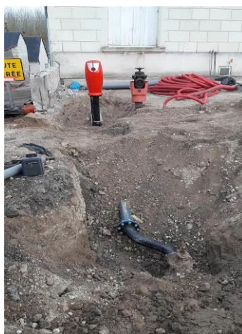
Travaux rue de Saumur La Chapelle sur Loire
