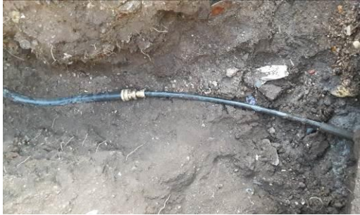
Réparation de branchement 85 rue de Tours La Chapelle sur Loire
